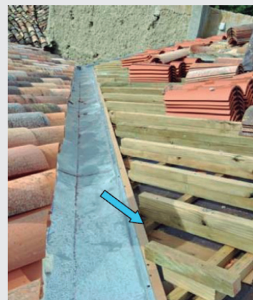
Ejecución de limahoya. El espacio entre rastreles y tejas debe quedar libre
