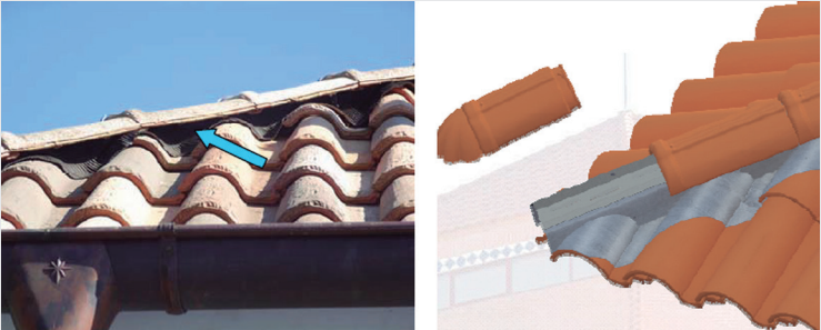
Limatesa ventilada para evitar acumulación de humedad bajo teja
