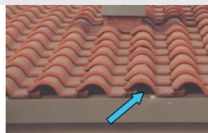
Alero libre para permitir la entrada de aire de la microventilación
