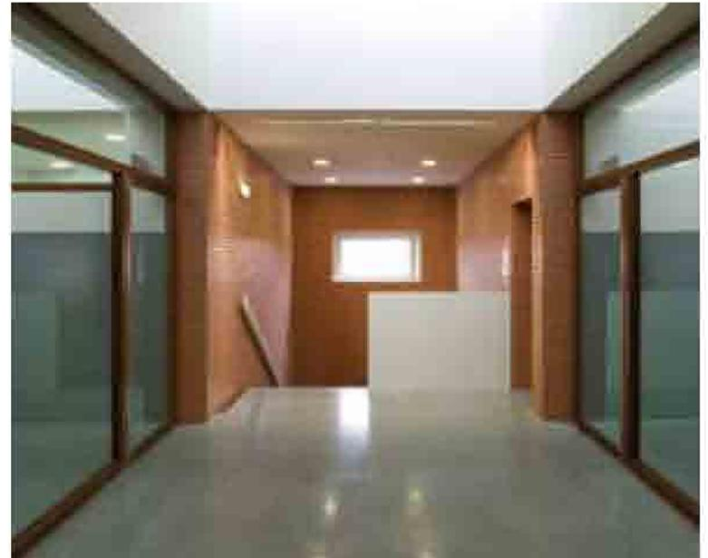
Se ha utilizado el ladrillo como elemento integrador del edificio con su entorno. Con un único material se ha dado respuesta a los diferentes requerimientos del cerramiento exterior, utilizándolo en la configuración de sus fachadas, en las celosías que delimitan los patios o en el revestimiento del techo de la marquesina de acceso. Alguno de estos paramentos tiene continuidad en el interior manteniendo el mismo material.
