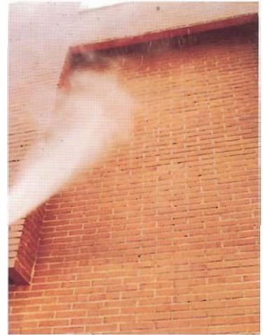
Empapamiento previo de la fábrica. La saturación con agua de las zonas inferiores de la pared es necesaria para evitar que absorban las escurriduras del agente de limpieza que se aplica en la parte superior.
