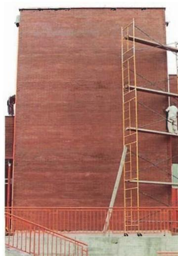
La planificación de la limpieza tiene que prever las diferentes características de la suciedad a eliminar. Las plataformas o los andamios se utilizarán según la intensidad y duración de las operaciones de limpieza sobre la fachada. El arrastre de la solución limpiadora, de arriba hacia abajo, se garantiza con la aportación de la cantidad de agua limpia adecuada.
