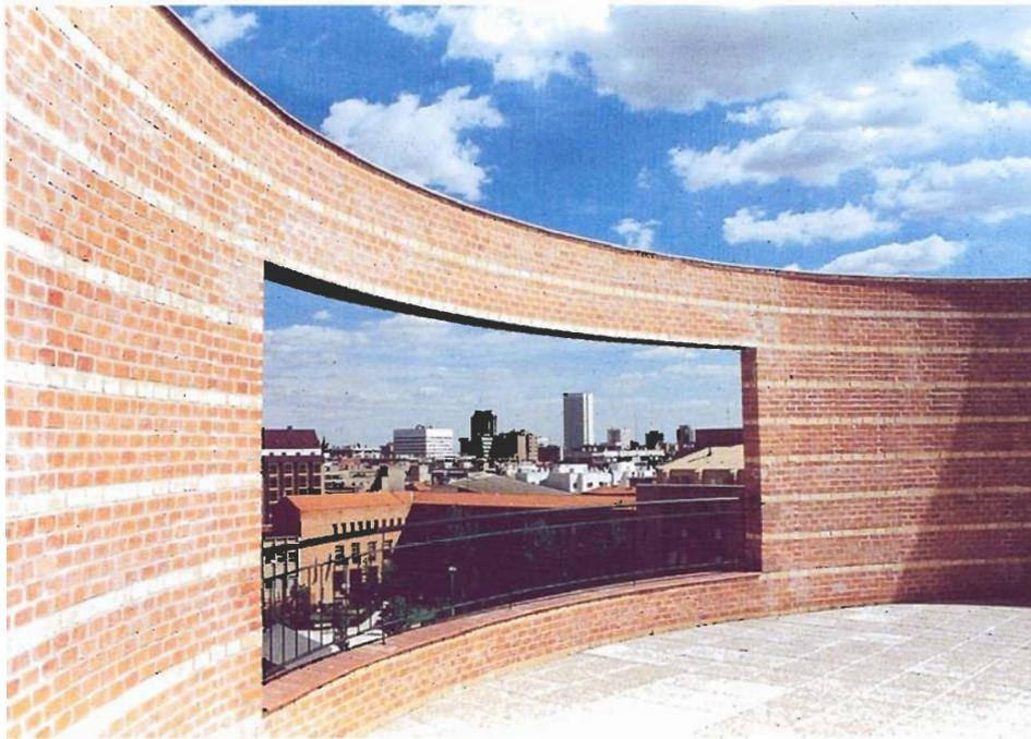
Fig.41. Dintel curvo de la esquina de la Plaza de la Remonta. Necesidad de armado tridimensional.
