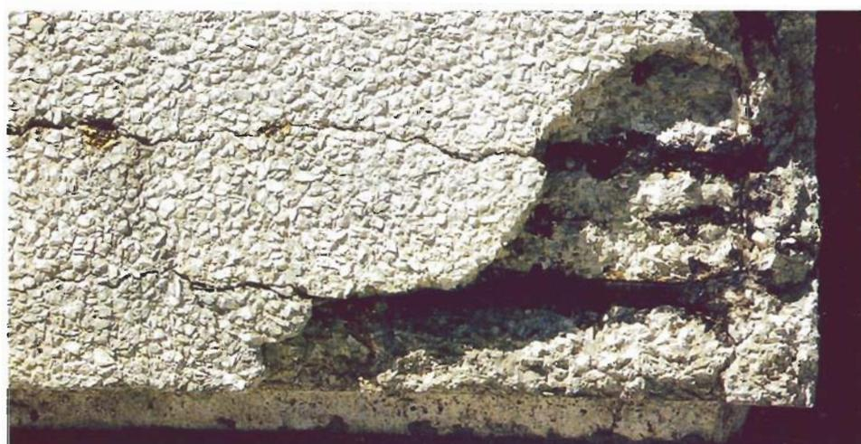
Fig.7. Armadura espacial o tridimensional, Murior-RE conformada por dos alambres longitudinales soldados por anillos verticales distanciados regularmente, función de los huecos de las piezas cerámicas.
