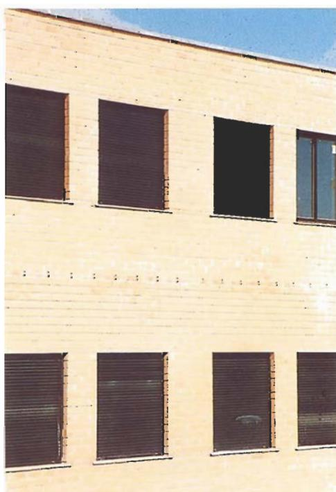
Fig. 76.—La fachada del Instituto de Vinaroz (V. Dualde). En el tendel de apoyo se alternan las "impostas" de ventilación y las ciegas.
