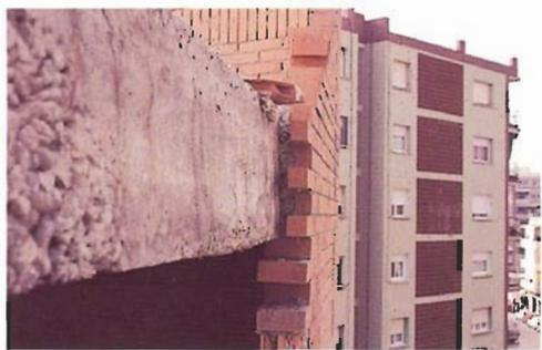
Fig. 6.—Disposición habitual de unos recortes de ladrillo cubriendo el canto del forjado. La estabilidad de la hoja exterior queda comprometida, pues es impredecible el comportamiento de su apoyo sobre un conjunto tan heterogéneo.
