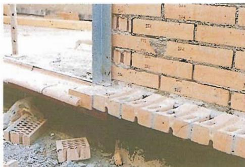
Fig. 75.—Impostas de soporte y ventilación en la piscina de Ulefiá (Ll. Clotet e I. Paricio). Excepcionalmente el alfeizar enrasa con el tendel de impostas. Obsérvese el angular como premarco fijado a la hoja interior.
