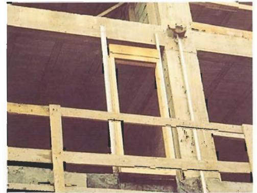
Fig. 55.—Muestra de la colocación de premarco y la carpintería.
