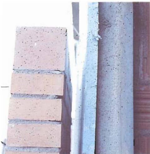
Fig. 65.—Vista de la hoja exterior junto a un hueco mostrando la situación del premarco, la cámara de aire y el dado de apoyo del dintel.
