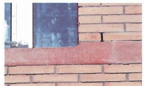
Fig. 43.-Llaga de ventilación sin mortero.
