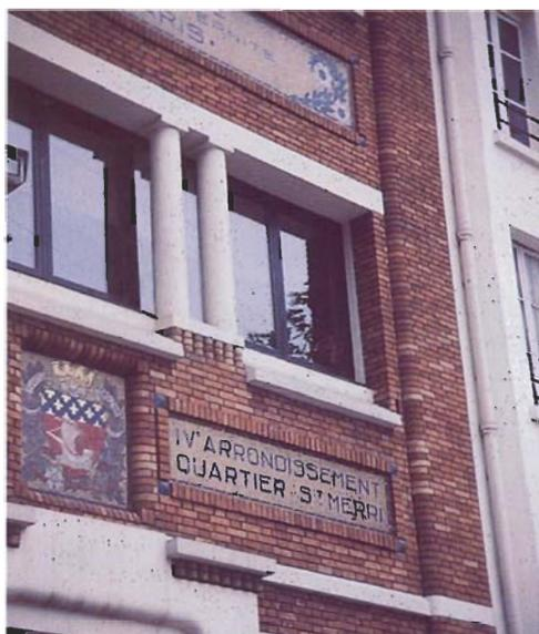
Fig. 81.-Los tradicionales mainels permiten soportar la hoja exterior sin romper la imagen de la ventana apaisada.
