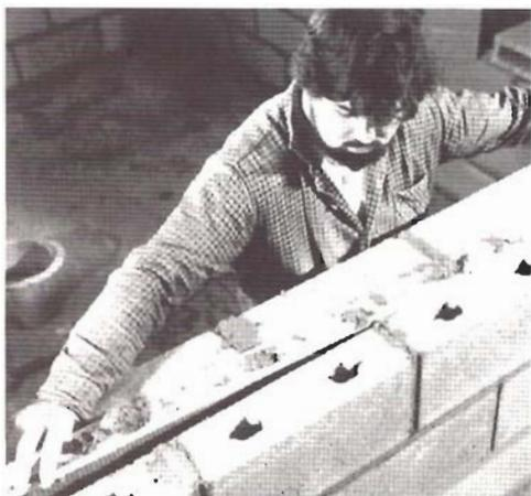
Fig. 18.—Uso de una tablilla elevable para mantener limpia la cámara.
