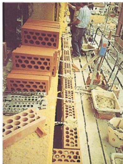
Fig. 57.—Las lañas de fijación de la hoja exterior.
