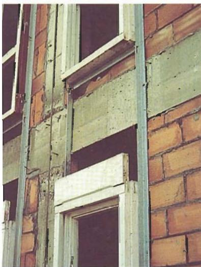
Fig. 56.—Vista de la obra que las carpinterías se fijan a los premarcos y estos a los bordes de los forjados. La hoja interior se montó posteriormente pisando las garras de los premarcos.
