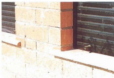
Fig. 77.—La carpintería está enrasada con la cámara de aire y la persiana enrollable cae sobre el alfeizar. El quicio cierra la relación entre la hoja exterior, la carpintería y el alfeizar.
