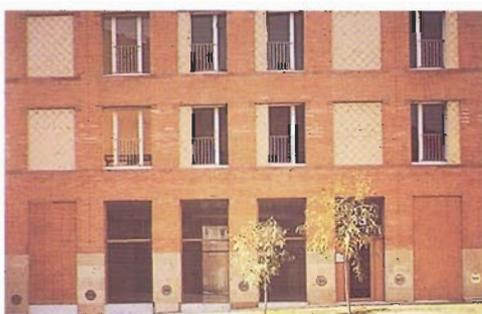
Fig. 89.-Las ventanas de la Villa Olímpica tienen carpinterías de tamaños diversos dentro de un hueco o tipo de la hoja exterior (L. Clotet, I. Paricio).
