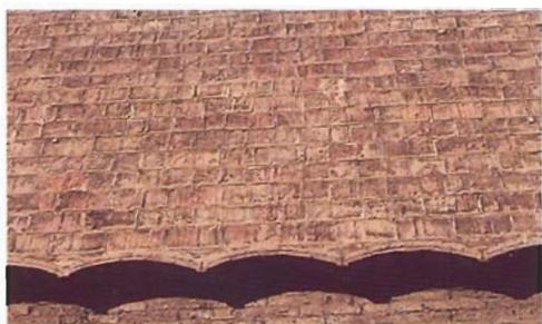
Fig. 12.—Solución de principios de siglo con apoyo en escarpas metálicas.
