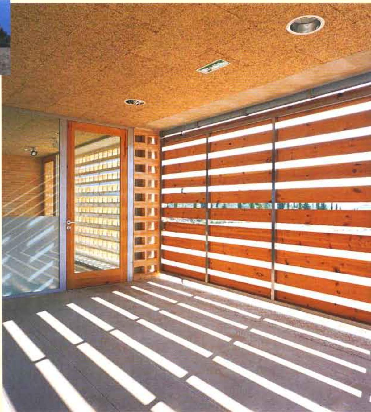
Las puertas correderas exteriores, que cierran en sus dos extremos la galería central, se resuelven con un bastidor de acero inoxidable mate de perfilera hueca al que se atornillan tablonés de sección rectangular (175 mm x 50 mm) de pino vacsolizado tratado en autoclave.
