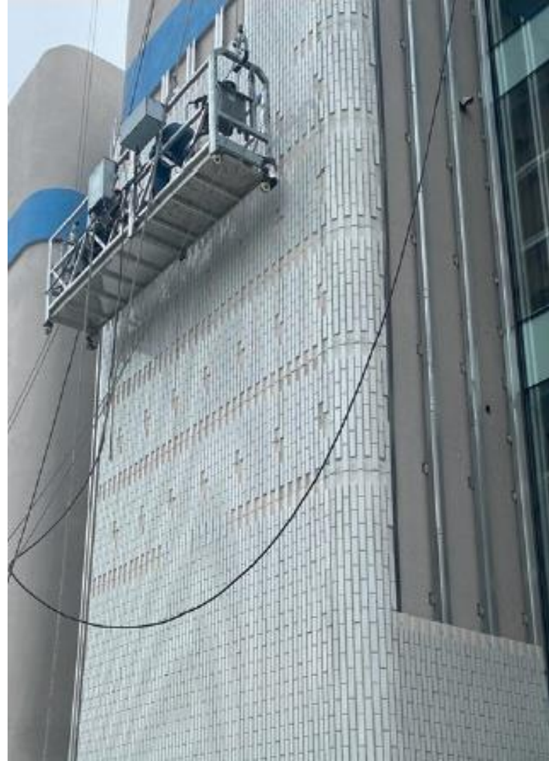
Hospital de Paitilla (Panamá) TASH arquitectos
