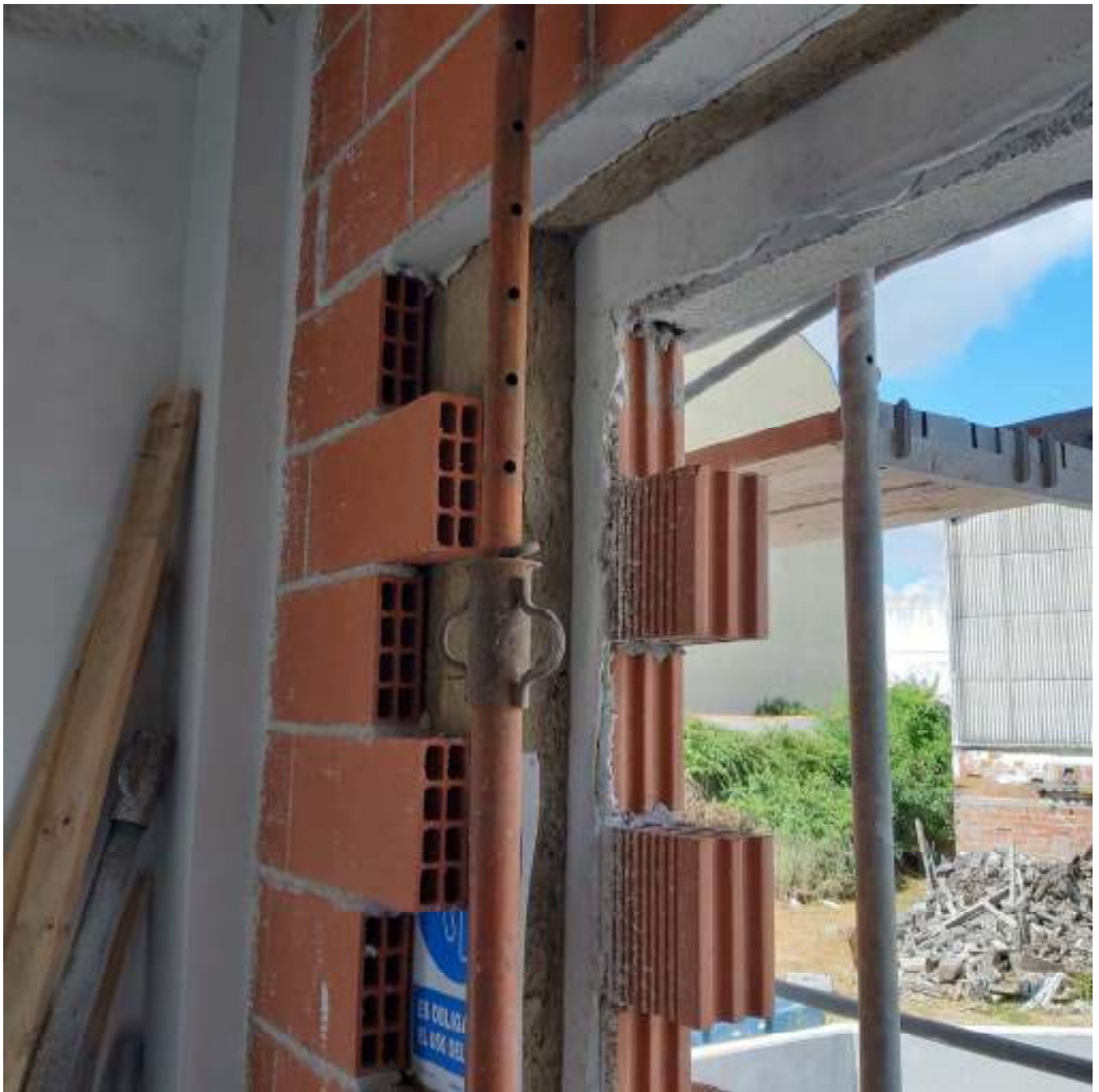
Vista de la composición de la fachada.
