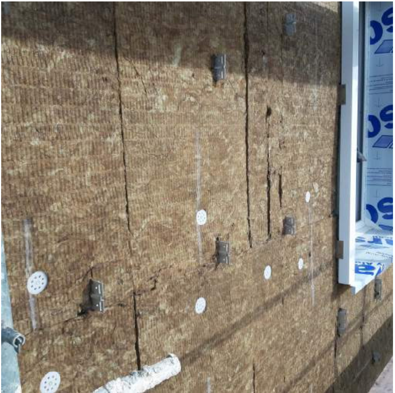
Capa de lana exterior de la fachada ventilada.
