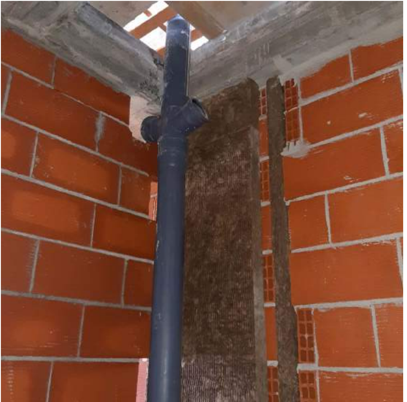
Encuentro entre paredes medianeras.
