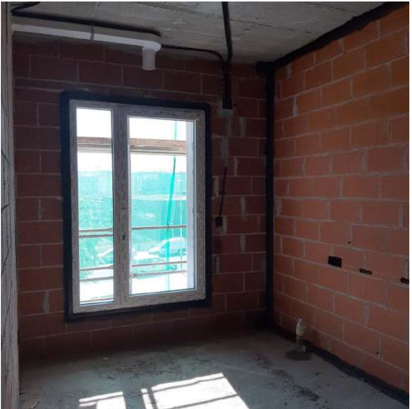
Lámina elástica para la hermeticidad (mejora acústica notable) en medianeras entre viviendas y en fachadas
