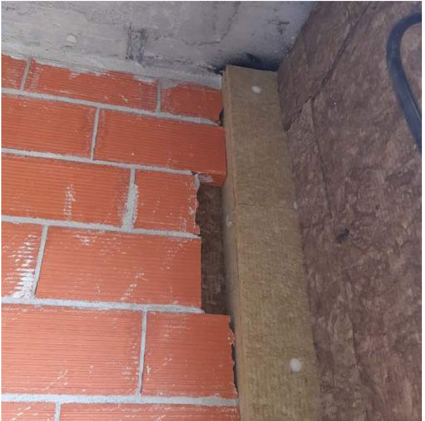
Encuentro medianera entre viviendas con fachada.
