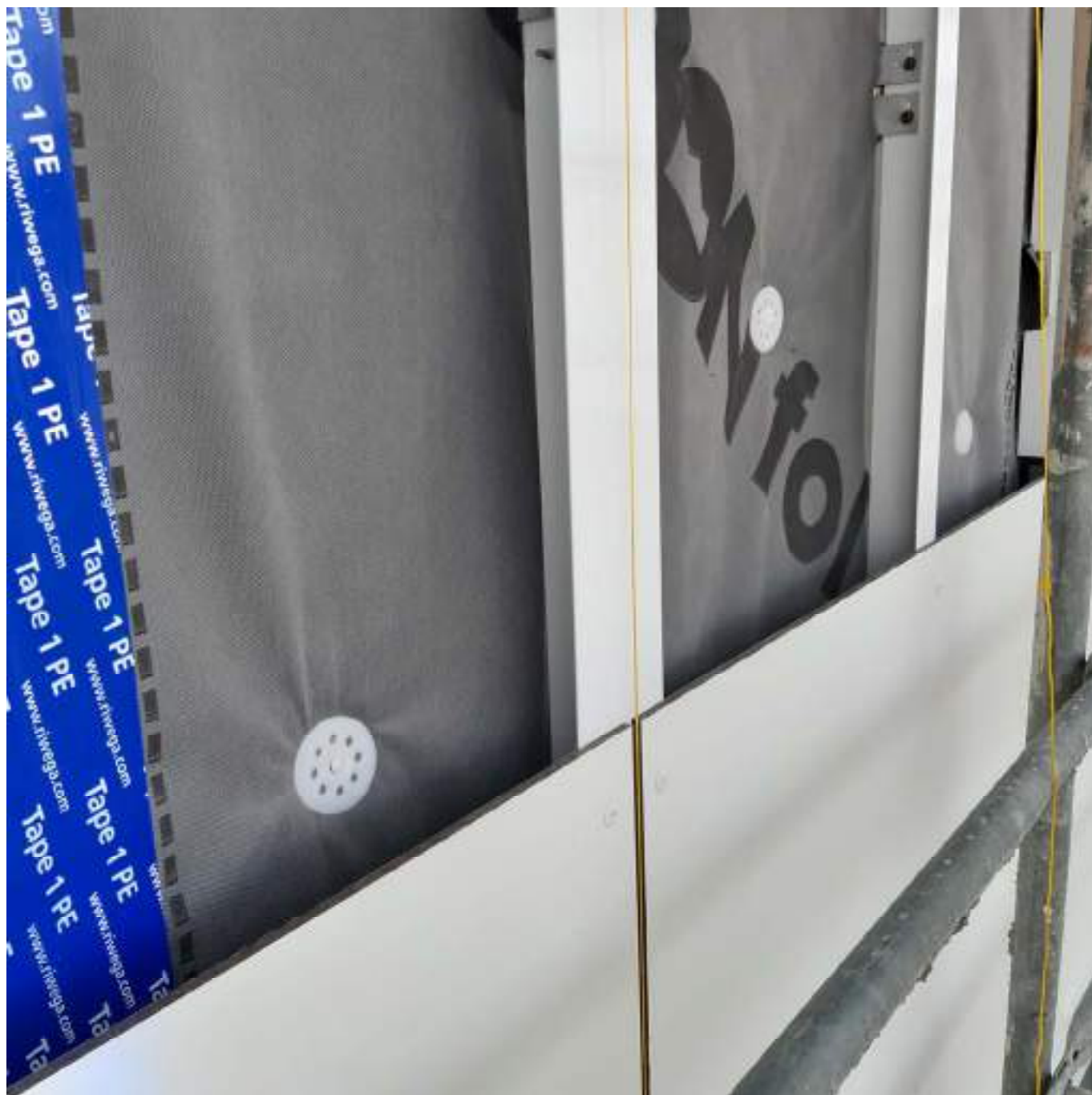
Fachada ventilada, panel Trespa + velo sobre lana de roca.
