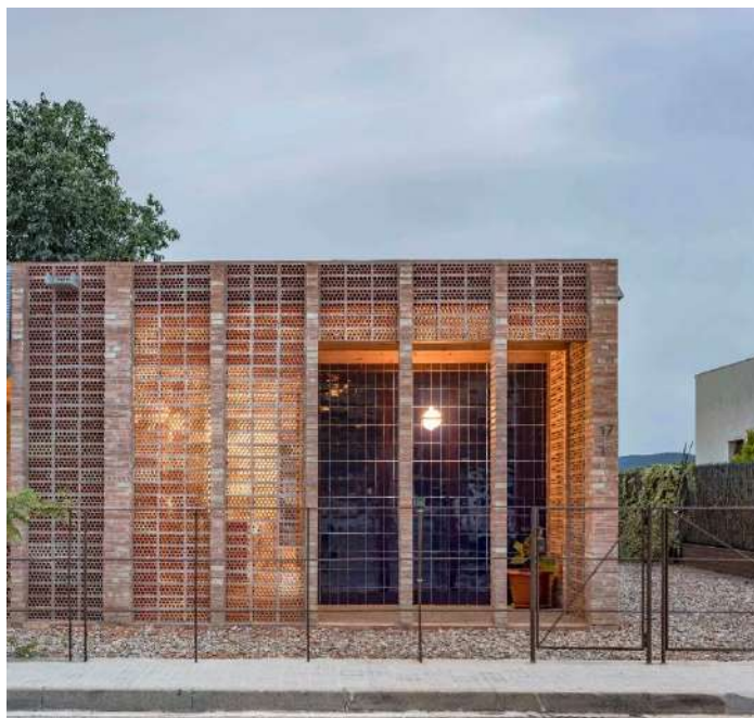
Vivienda unifamiliar en Sant Esteve de Palautordera (Barcelona)
