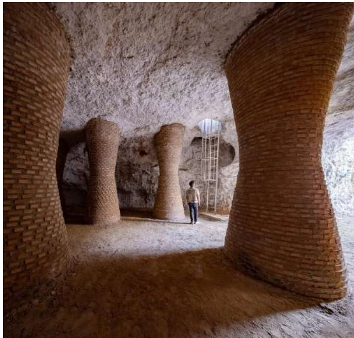
Estabilización de sistema de cuevas en Tomelloso (Ciudad Real)
