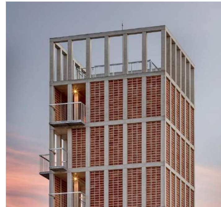
Torre de prácticas de bomberos de la Vall d'Hebron (Barcelona)
