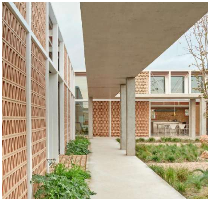
Vivienda unifamiliar en Albons (Gerona)
