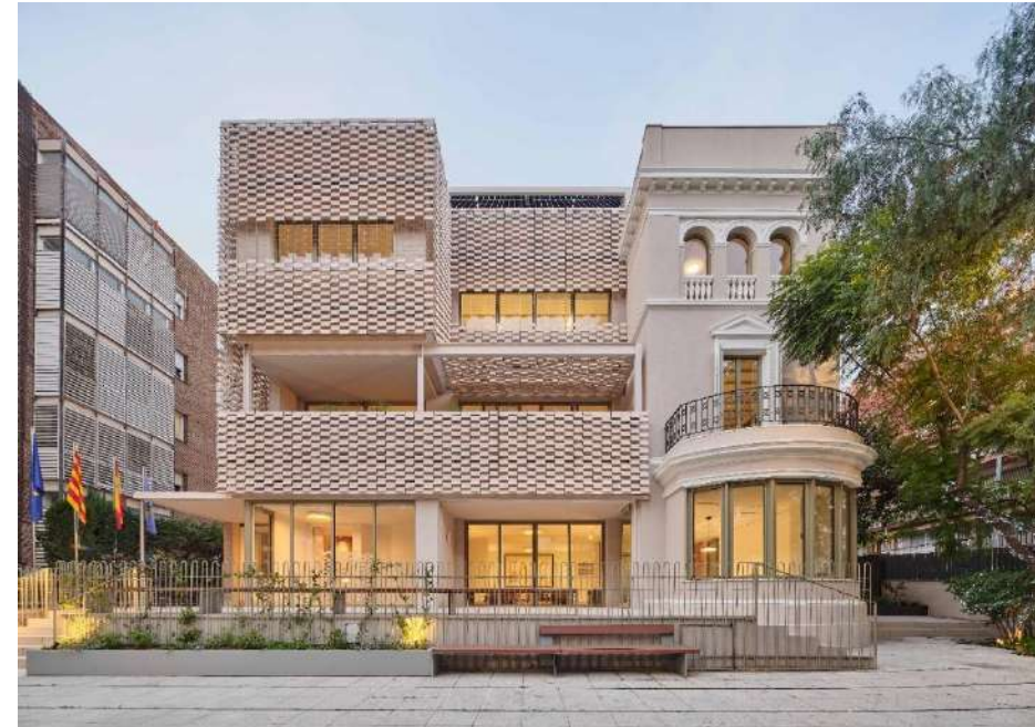
Rehabilitación de la Sede del Colegio de Ingenieros de Caminos, Canales y Puertos (Barcelona)
