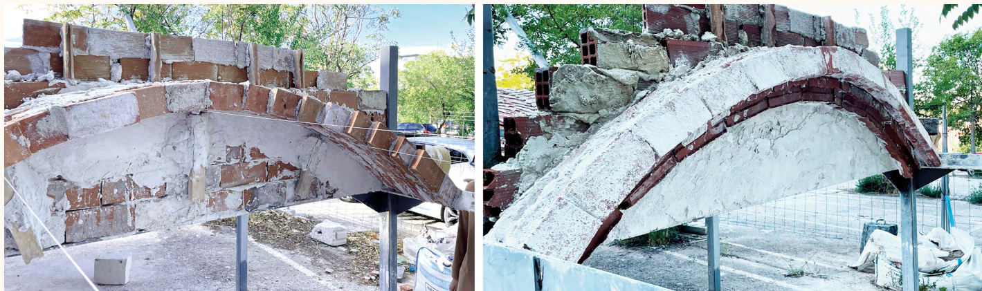
Figura 10. Construcción de dos bóvedas de cañón en la Escuela de Arquitectura de la Universidad Politécnica de Madrid: una con hojas verticales planas (izquierda) y otra con hojas cónicas convexas (derecha).
