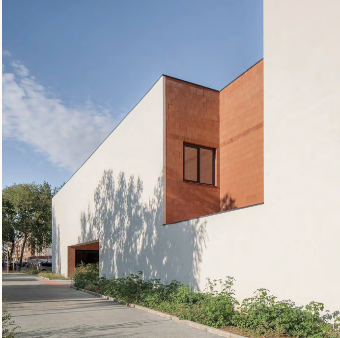
Figura 9. Centro Sociocultural El Ensanche. INCOSA, Parra Arquitectos. Fotografía: Imagen Subliminal.
