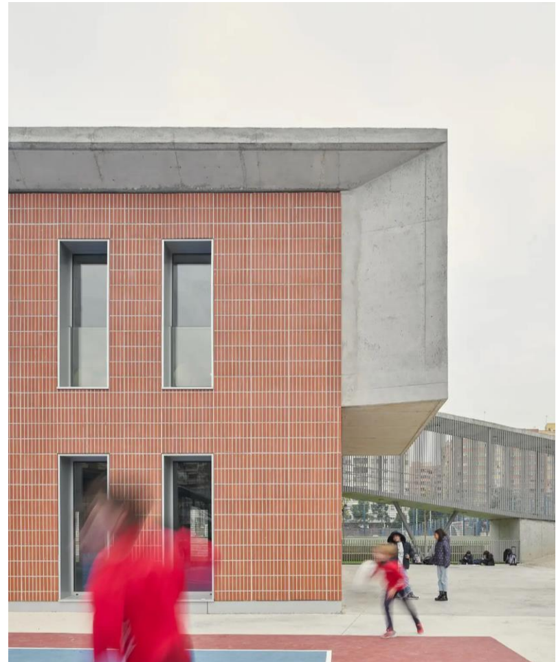
Edificio polivalente y F.P. en Colegio San Agustín (Zaragoza) Bernabad Arquitectura + Ingeniería
