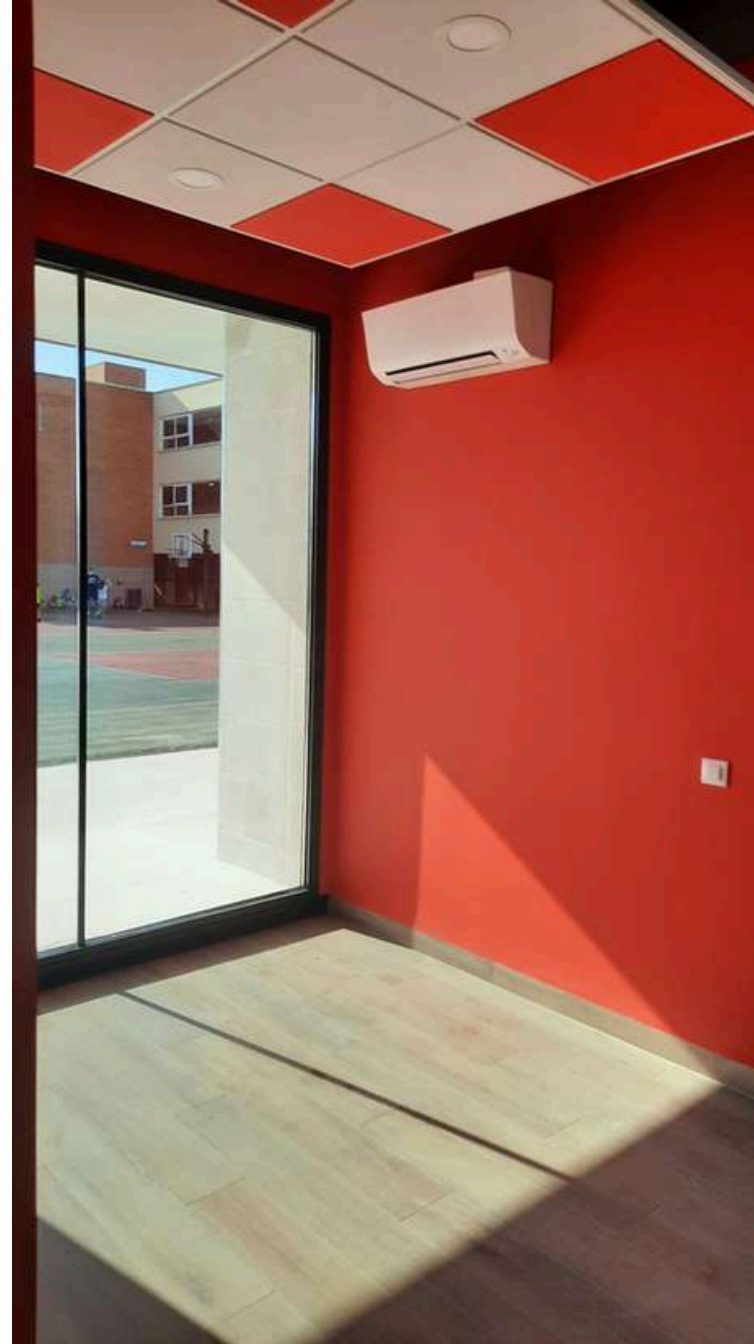
Bandejas de techo absorbente con instalaciones vistas Distribución en tabiques de yeso laminado y mamparas de vidrio
