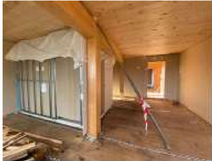
Muros / Forjados CLT
