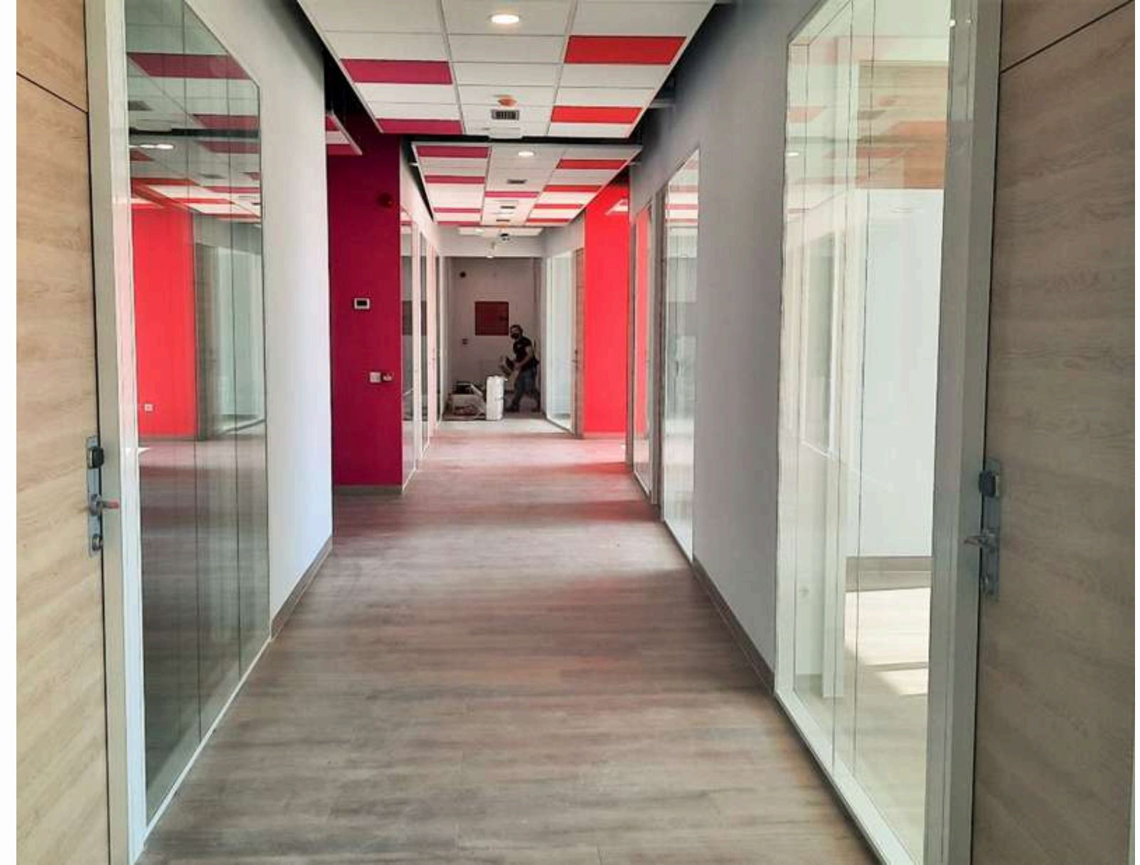
Bandejas de techo absorbente con instalaciones vistas Distribución en tabiques de yeso laminado y mamparas de vidrio
