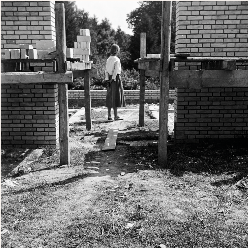
Figura 7. Construcción de vivienda en Hellebaek (Dinamarca) de Jorn Utzon
