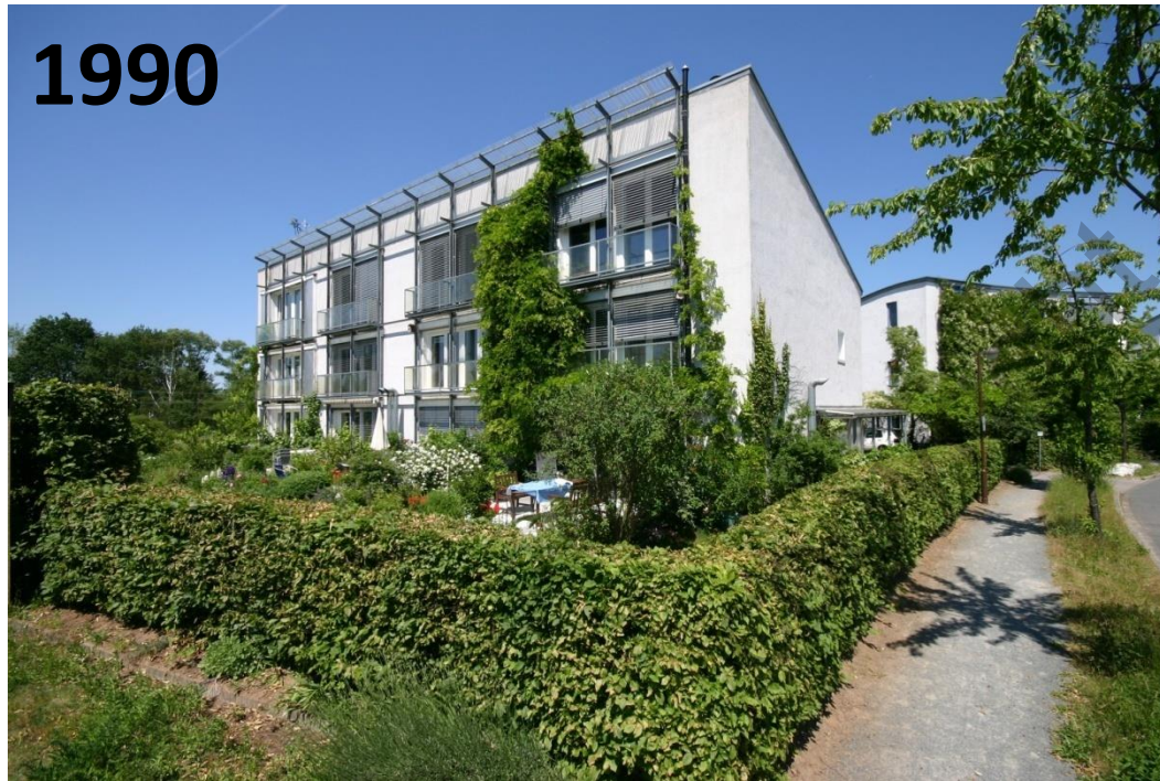
1990: Primer edificio Passivhaus: 4 viviendas adosadas en Darmstadt-Kranichstein
