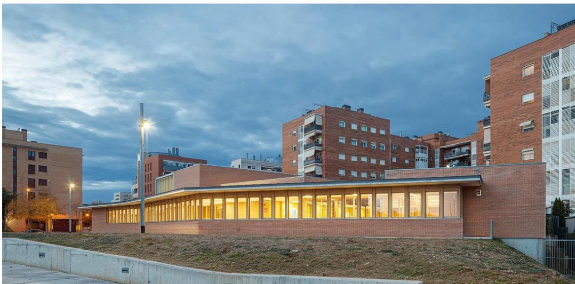
La pieza cerámica manual refuerza la escala doméstica del edificio, creando un ambiente más amigable para los usuarios. Además, se ha propuesto un cerramiento exterior autoportante anclado a la estructura para dar continuidad al aislamiento térmico y evitar puentes térmicos. La combinación de cerámica con muros de hormigón visto permite los voladizos que soportan los grandes lucernarios.
