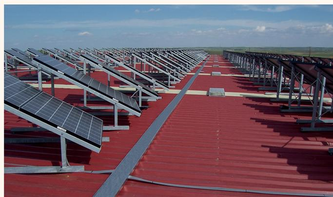
Figura 5. Instalación de paneles solares fotovoltaicos en cubierta.
