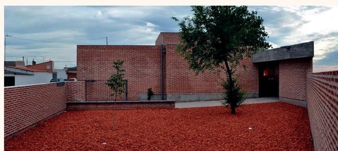
Figura 14. Cubierta con material cerámico machacado como protección del asfalto impermeabilizante sobre membrana.
