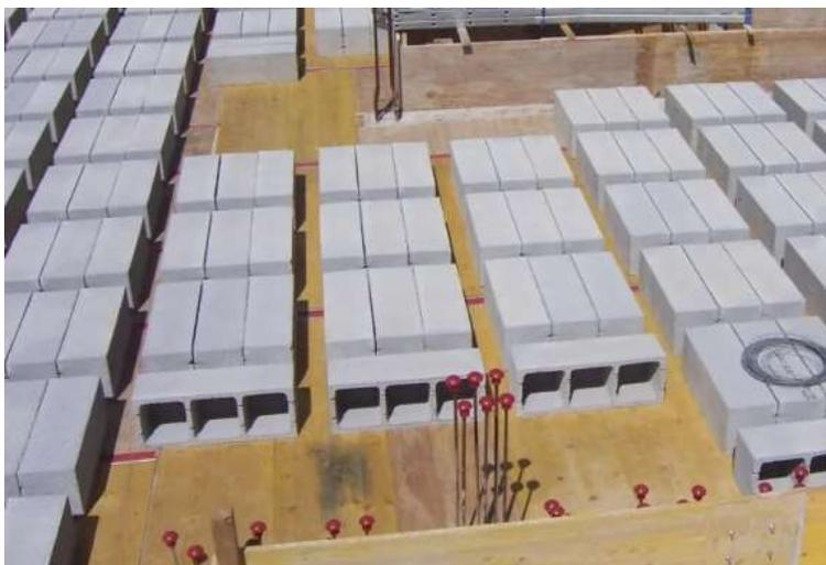
MÓDULO DE 3 PIEZAS CASETONES CONVENCIONALES DE HORMIGÓN SE NECESITAN 4 MÓDULOS PARA CONFIGURAR EL CRUCE DE DOS NERVIOS
