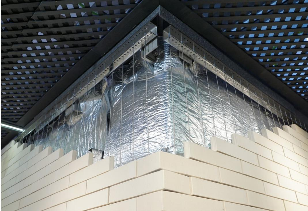
**'CABLEBRICK'** fachadas ventiladas ligeras de instalación "in situ" en seco, con estética y prestaciones de ladrillo cara vista. Fácil montaje. Múltiples modelos y formatos de piezas cerámicas.
