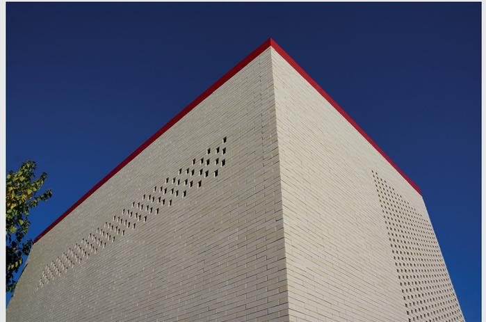
Figura 1: Fachada ejecutada con el sistema Cablebrick, fabricada y ejecutada por Cerámica Malpesa.
