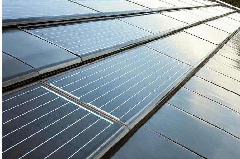
Imagen: Ejemplo de cubierta con teja cerámica y teja solar fotovoltaica
