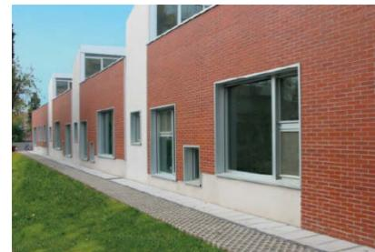
Imágenes: Ejemplo de pieza SATE cerámico prefabricado y obra construida con el sistema Termoklinker
