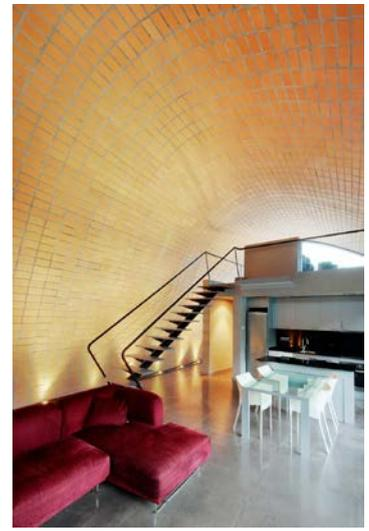
Imágenes: Obras construidas con el sistema cerámico prefabricado Flexbrick
