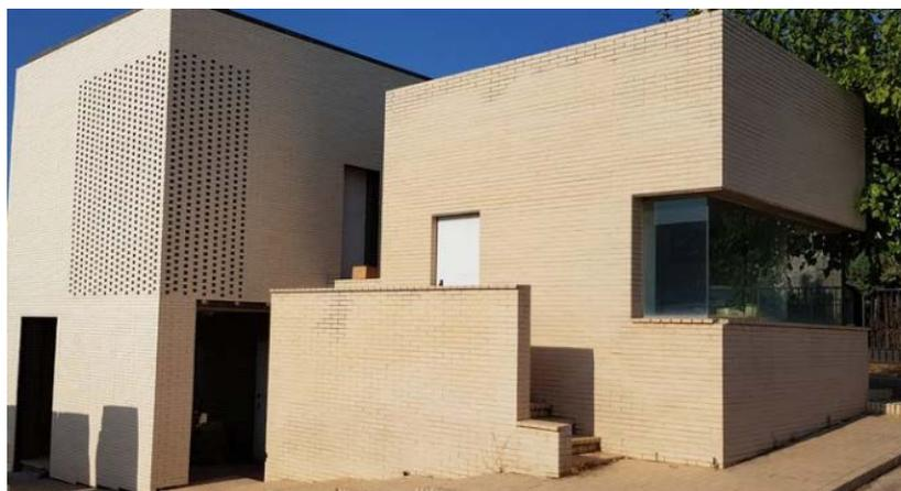
Imagen: Ejemplo de obra ejecutada con el sistema prefabricado 'Cablebrick'
