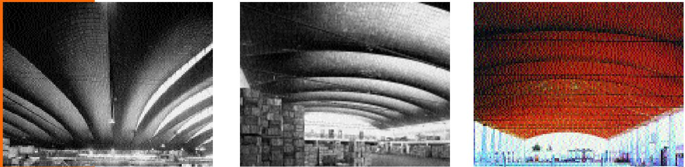
Fig.2 – Cubiertas laminares de cerámica armada.
