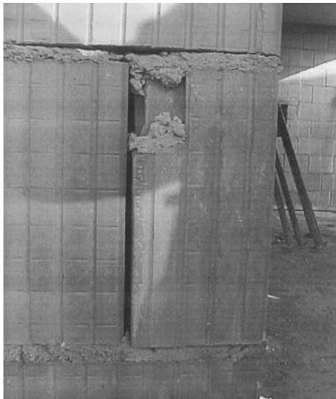
Error. No se colocarán piezas rotas en la construcción de los muros
