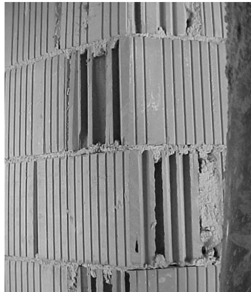
Error. No se colocarán piezas rotas en la construcción de los muros
