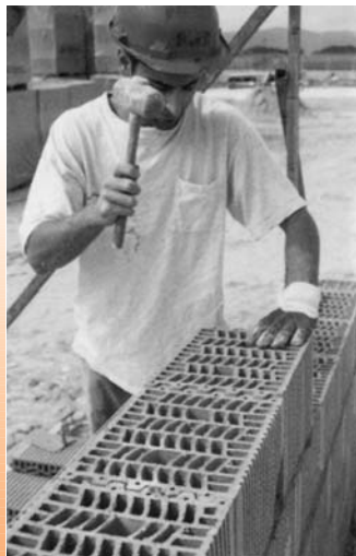
Golpear los bloques con una maza de goma para conseguir que el mortero penetre en las perforaciones
