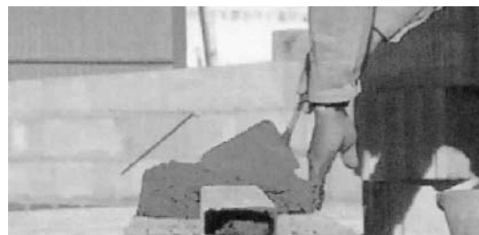
Con objeto de disponer en los tendeles suficiente cantidad de mortero, usar un listón de 3x5 a modo de guía para enrasar el mortero
