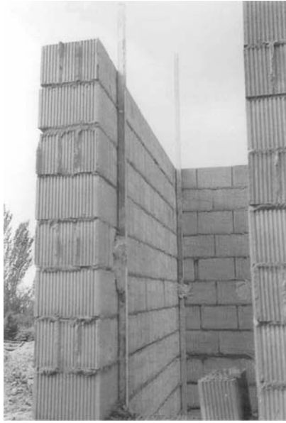
Colocación de miras
