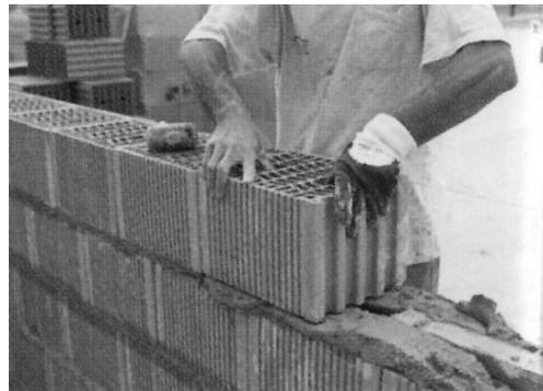
Colocar los bloques verticalmente, haciendo tope con los machihembrados
