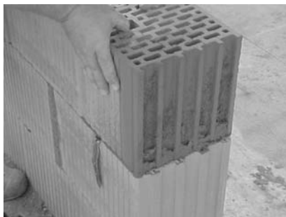
Empleo de piezas cortadas en el muro
