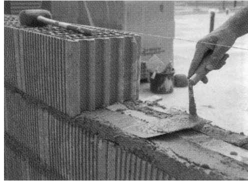
Extender el mortero usando el listón a modo de guía
