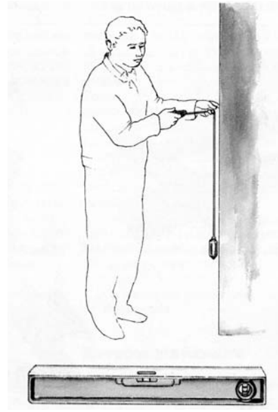
Uso de la plomada (verticalidad) y el nivel (horizontalidad)
