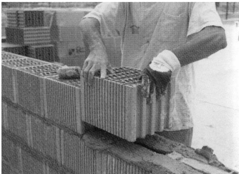
Retirar el listón para proceder a la colocación de los bloques
