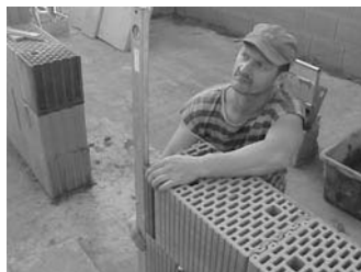
Comprobación de la vertical con el nivel de burbuja
