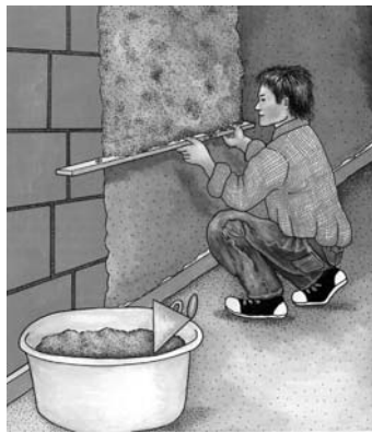
Revestimiento de los muros Termoarcilla
