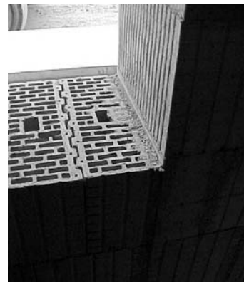
Junta vertical entre bloques ejecutada correctamente
