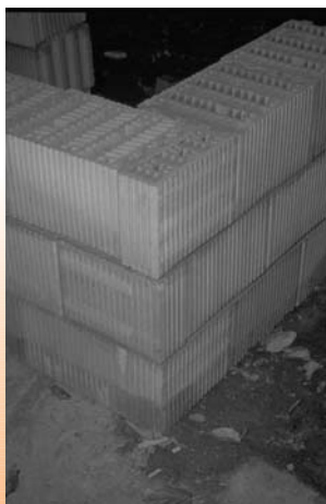
Muros Termoarcilla de una sola hoja, como alternativa a los muros multicapa, dado su elevado aislamiento térmico
